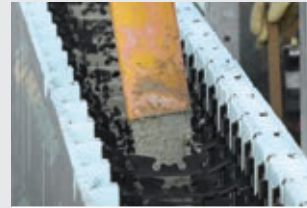
Pour concrete into walls
