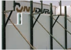
Align wall for concrete pour
